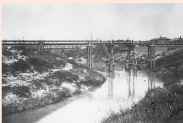
Il primo ponte in ferro sul Meduna a Corva. Costruzione iniziata nel 1882. Qui si vede aggiustato con travi in legno dopo la Prima Guerra Mondiale. Demolito nel 1951.
