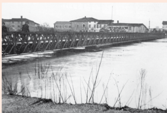
Ponte tipo Baley 1951-1958. Visto durante la piena del 1958.
